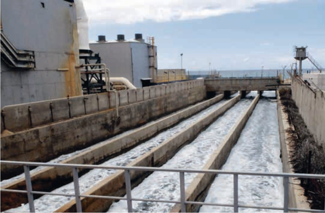
Auch die Entsalzungsanlage in Hadera versorgt Israel mit Wasser. 70 Kilometer weiter östlich herrscht der Mangel
